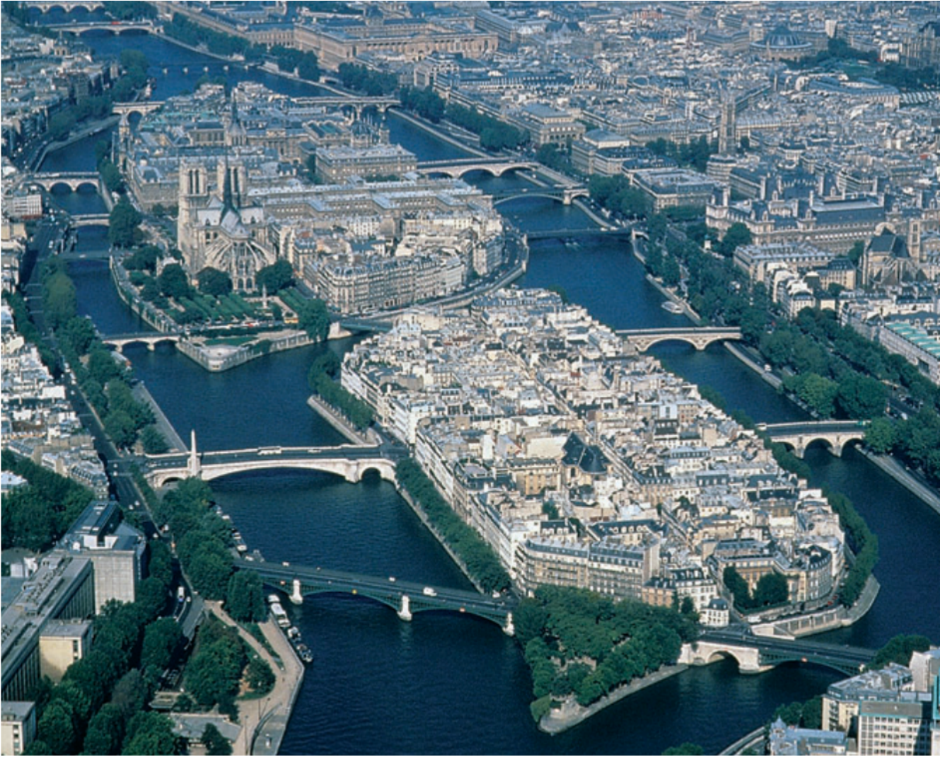
FIGURE 4 : Vue des ponts depuis l'Ouest.
