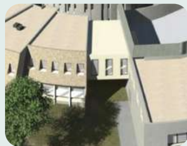
Bureaux département DCI
