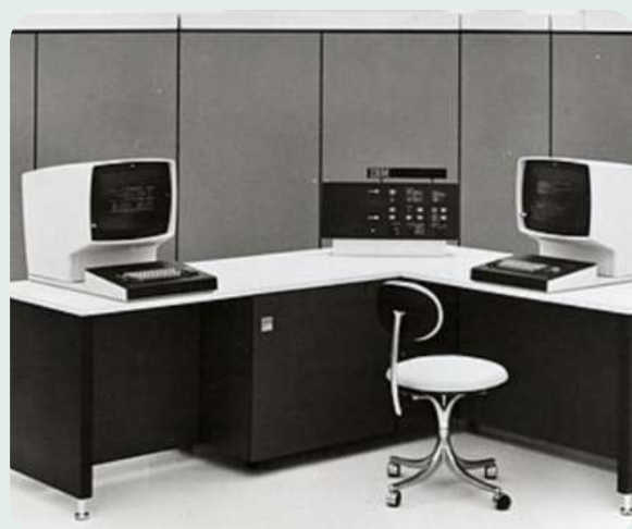
CNUSC 1981 : ordinateur IBM 3033 U8 sous le système d'exploitation MVS et JCL (Job Control Language), offrant une mémoire de 8 Mo et un cycle de base de 57 nanosecondes, pour une puissance d'environ 6 Mips. La configuration était complétée par 11 unités de disques magnétiques de type IBM 3350 (temps d'accès moyen: 25 millisecondes; débit: 1,2 Mo/s), représentant une capacité de 7 Go en ligne, et 8 unités de bandes magnétiques 3420 étaient connectées pour les sauvegardes.
